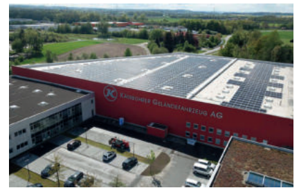
Laupheim | 1,7 MWp | SolarEdge Technik
