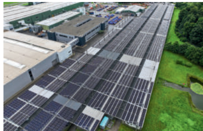
Bad Waldsee | 2,8 MW
