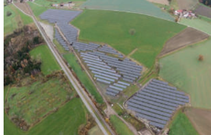
Bad Waldsee | 8,2 MWp | 3 Trafostationen | 1 km Kabelweg bis zur Übergabestation
